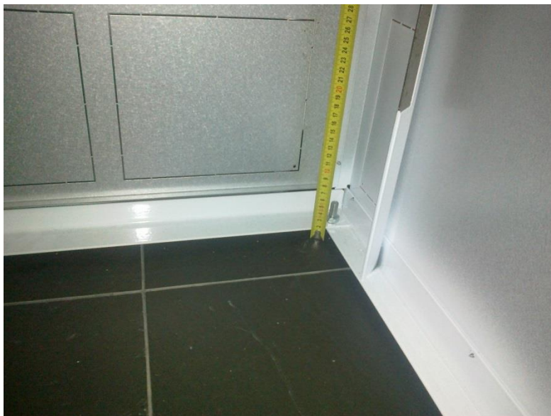
Zadní ztužovací nosník je možné při montáži dočasně demotovat. Spodní hrany postupů jsou 70 až 110 mm od podlahy v závislosti na nastavení výšky vyrovnávacích šroubů.
