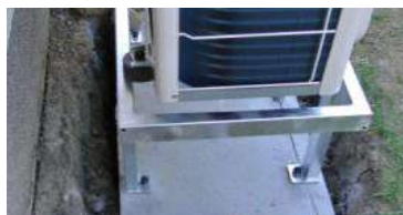
Obr 5 – konzole, konzole na betonovém základě, umístění konzole
