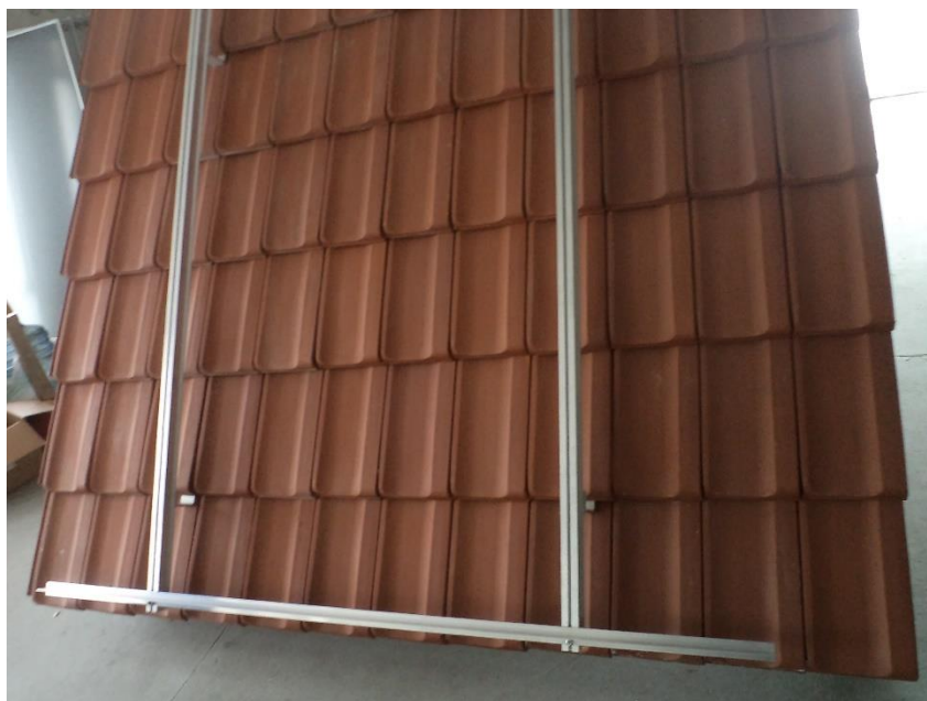
Pohled na postavenou konstrukci
