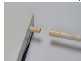
Nasunutí hadice, zajistit sponou (spona dodávka montážní firmy)
