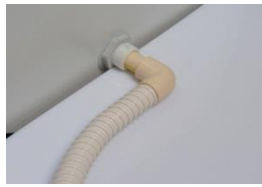
Nasunutí hadice, zajistit sponou (spona dodávka montážní firmy)
