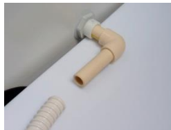
Napojení odvodu kondenzátu s 90°kolenem – příprava pro nasunutí hadice
