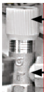
Přepouštěcí ventil (2) otočné kolečko (1)
