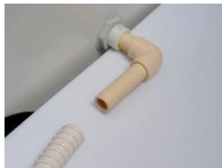
Napojení odvodu kondenzátu s 90° kolenem – příprava pro nasunutí hadice
